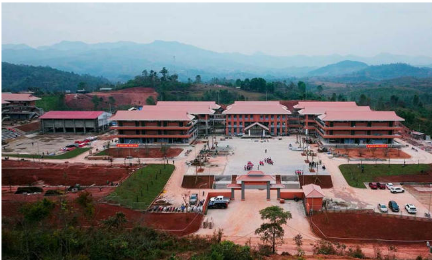
Trường nội trú liên cấp tiểu học và trung học xã Si Pa Phin được xây dựng tại thôn Nam Chim 1, xã Si Pa Phin, tỉnh Điện Biên. Hình: Tien The
